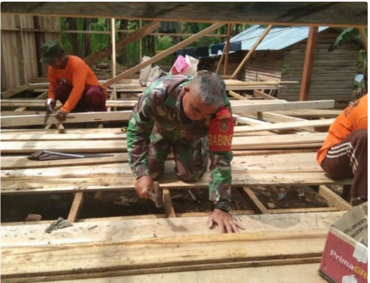
Sertu Sanu Pasang Papan Untuk Lantai Rumah
